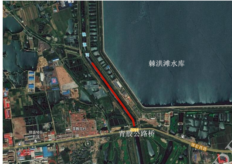
图 1-1 底泥处理区域
